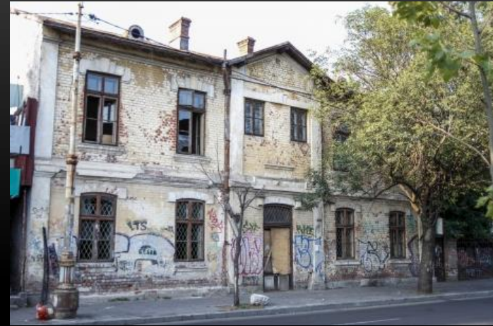
Clădirea Splaiul Independenței nr 2
